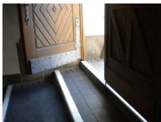
Stufe nach der Tür am Haupteingang
